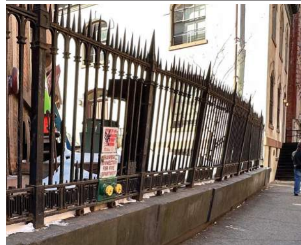
A35 - RESTORE SITE FENCE
