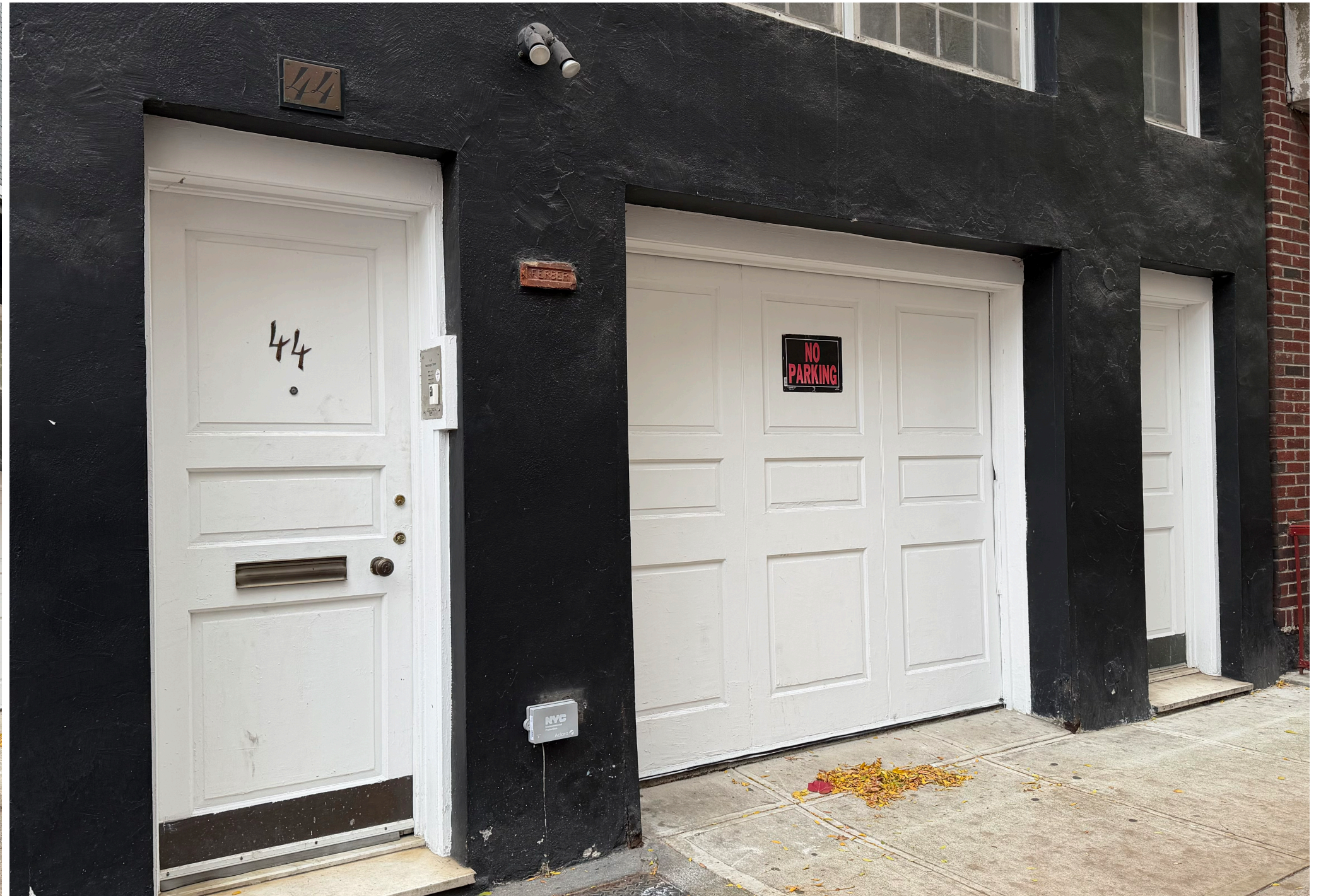
EXISTING GARAGE DOOR
