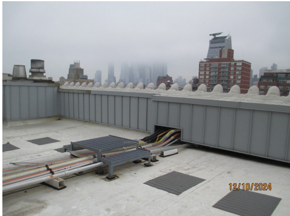
North parapet conduit chase
