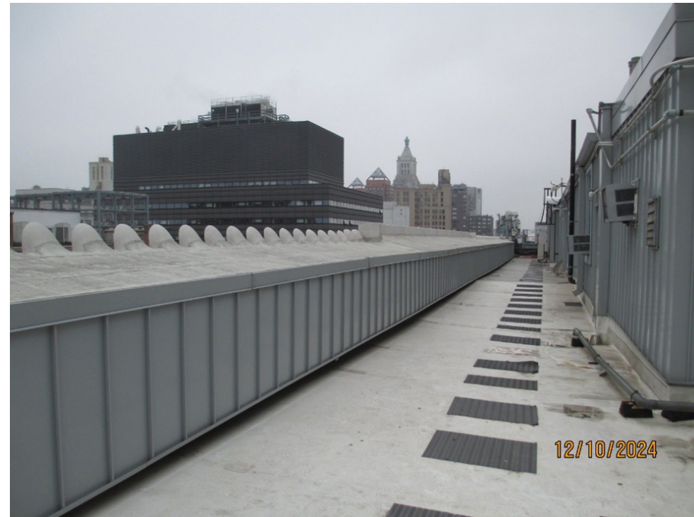
North parapet conduit chase
