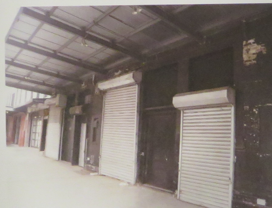
60-62 GANSEVOORT ST. - EXTERIOR EXISTING CONDITIONS
