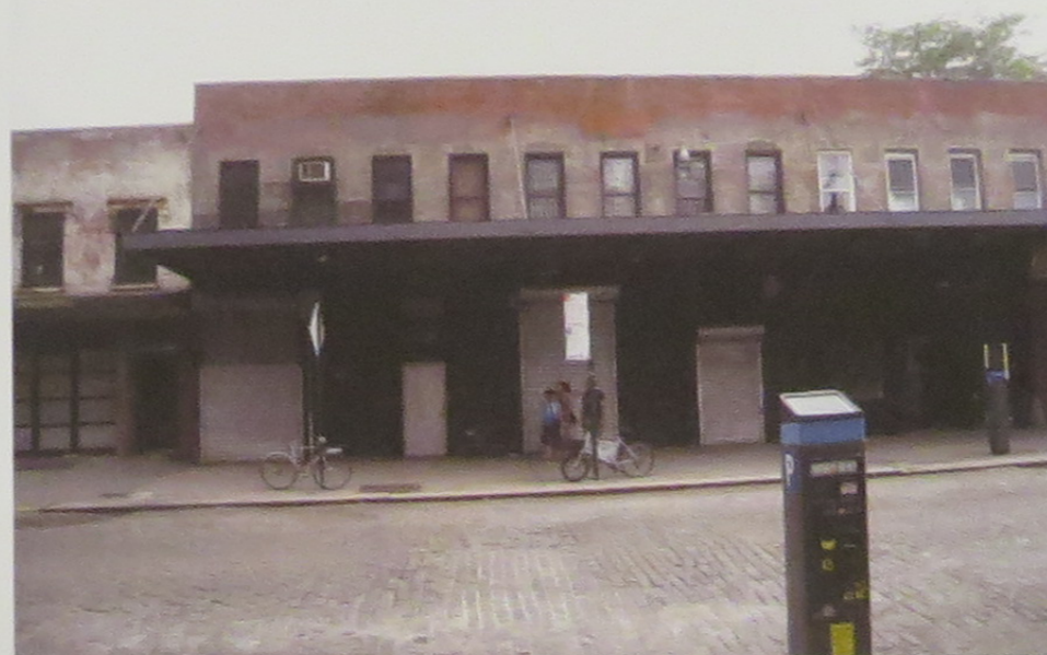
60-62 GANSEVOORT ST. - EXTERIOR EXISTING CONDITIONS
