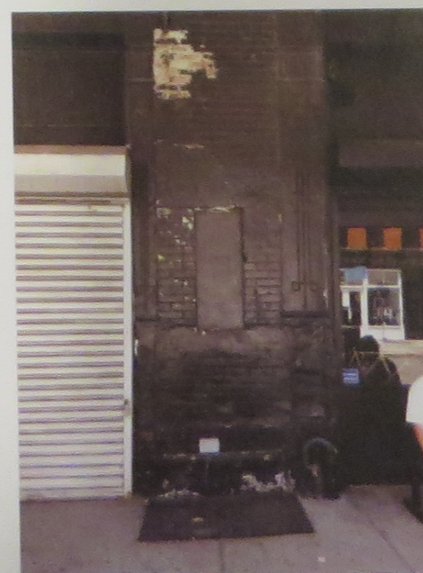
62 GANSEVOORT ST. - EXISTING CONDITIONS
