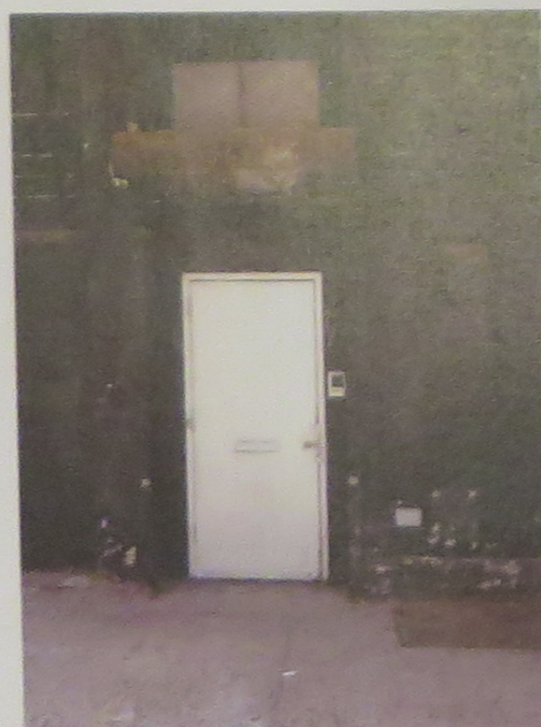
60 GANSEVOORT ST. - EXISTING CONDITIONS
