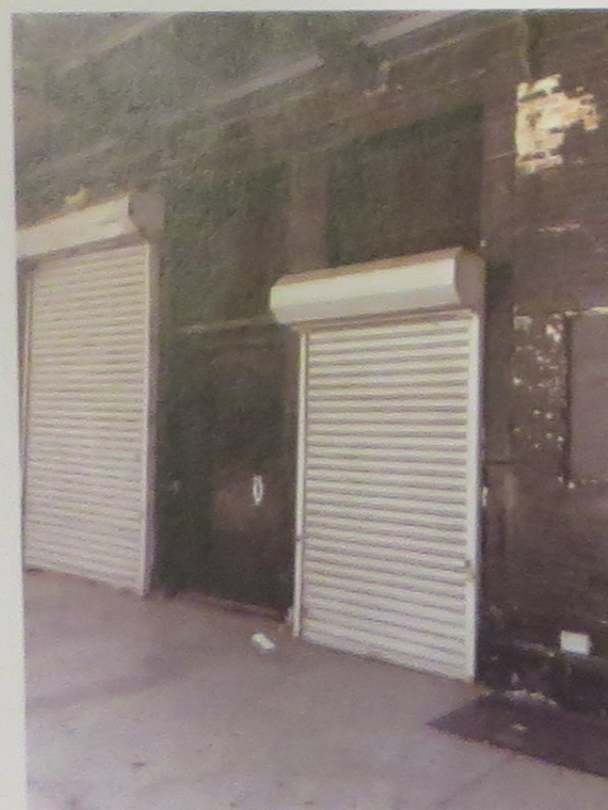
62 GANSEVOORT ST. - EXISTING CONDITIONS
