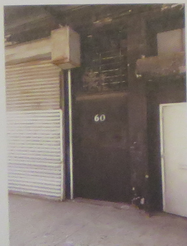
60 GANSEVOORT ST. - EXISTING CONDITIONS
