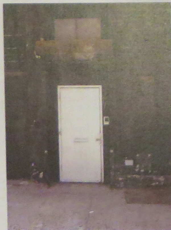
60 GANSEVOORT ST. - EXISTING CONDITIONS
