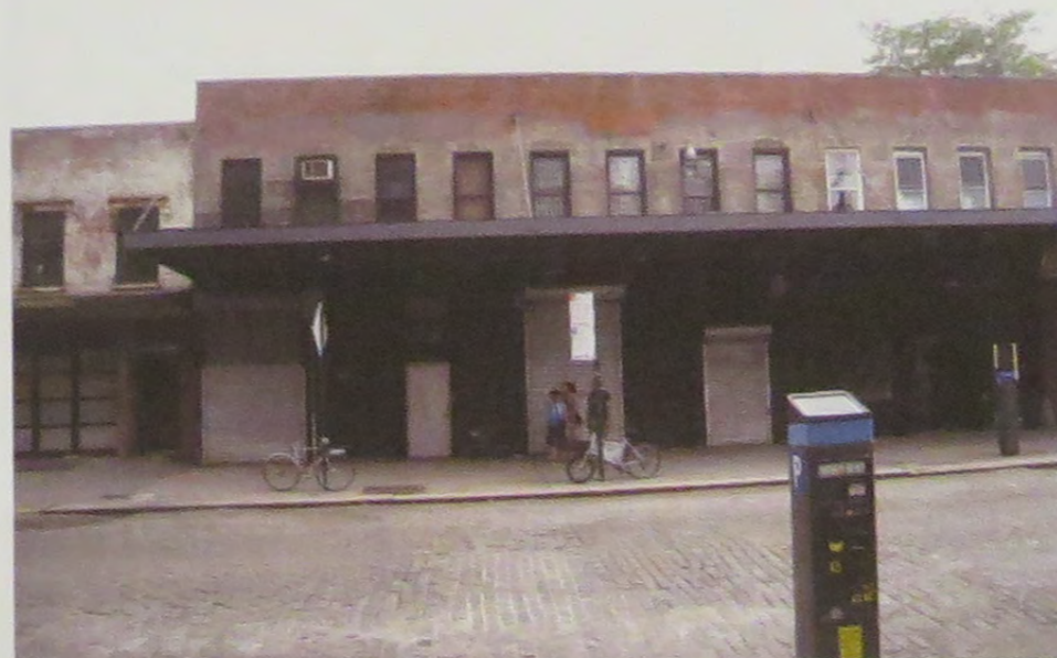
60-62 GANSEVOORT ST. - EXTERIOR EXISTING CONDITIONS
