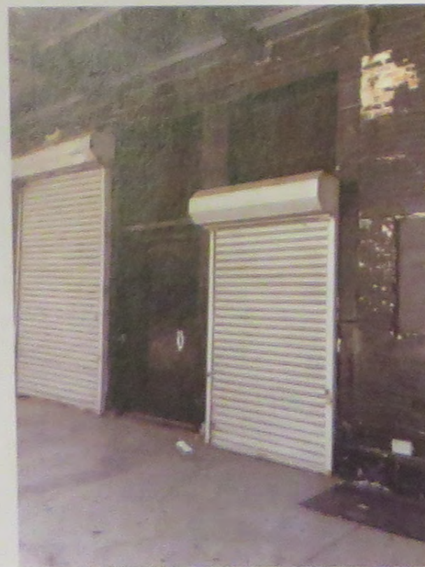
62 GANSEVOORT ST. - EXISTING CONDITIONS
