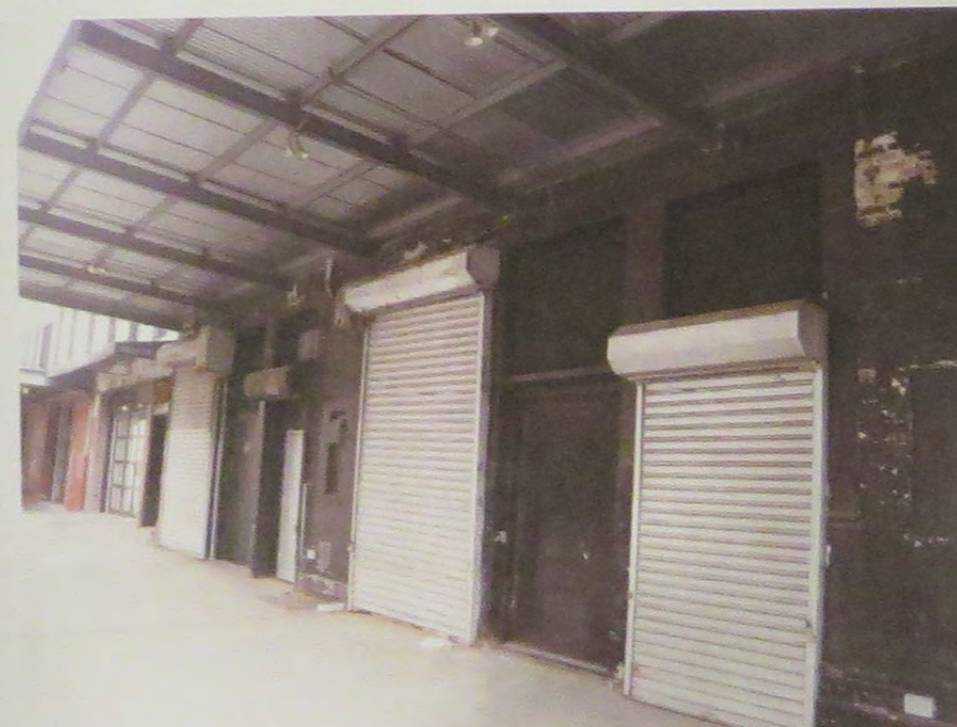
60-62 GANSEVOORT ST. - EXTERIOR EXISTING CONDITIONS
