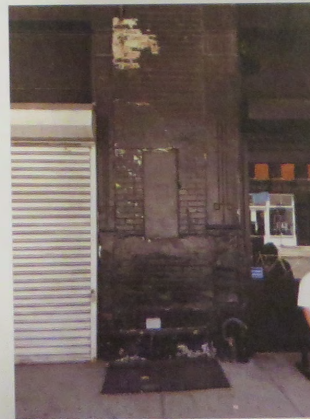
62 GANSEVOORT ST. - EXISTING CONDITIONS
