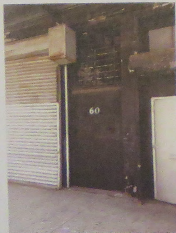
60 GANSEVOORT ST. - EXISTING CONDITIONS
