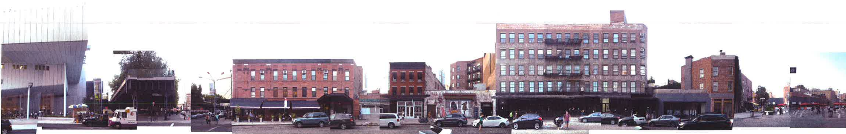
GANSEVOORT STREET - NORTH SIDE
