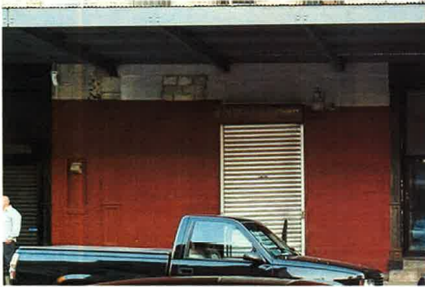
EXISTING INFILL AT 66 GANSEVOORT STREET
